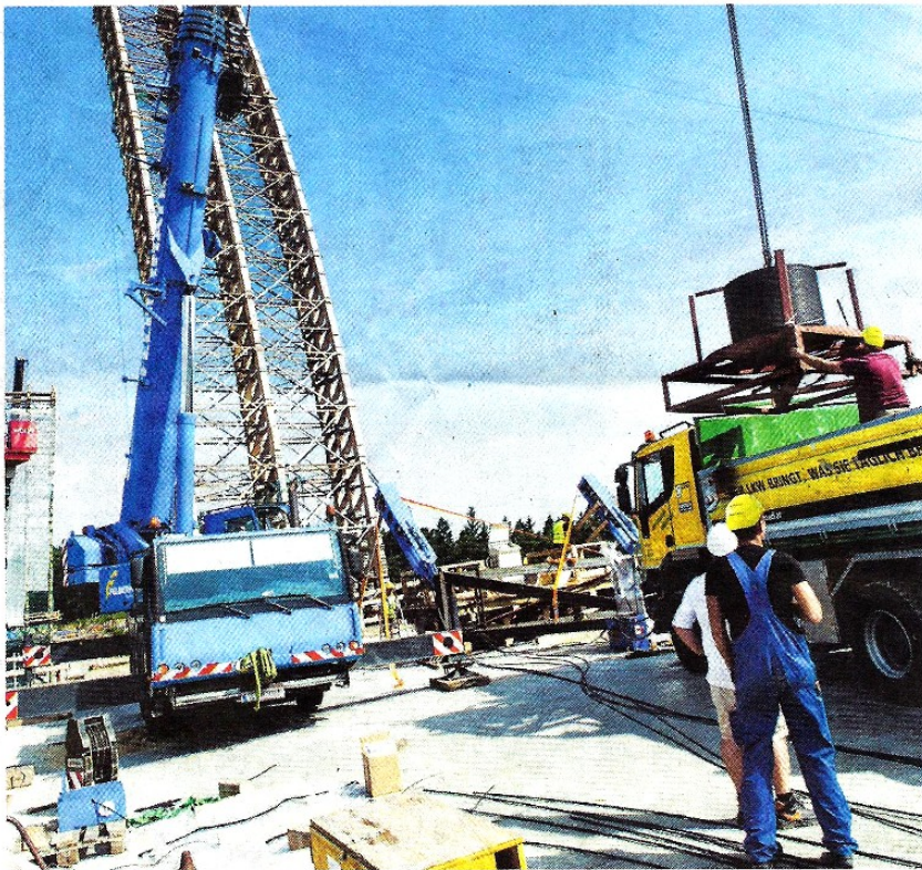
Der Baustart für den ersten Abschnitt der S34 könnte sich einmal mehr verzögern
